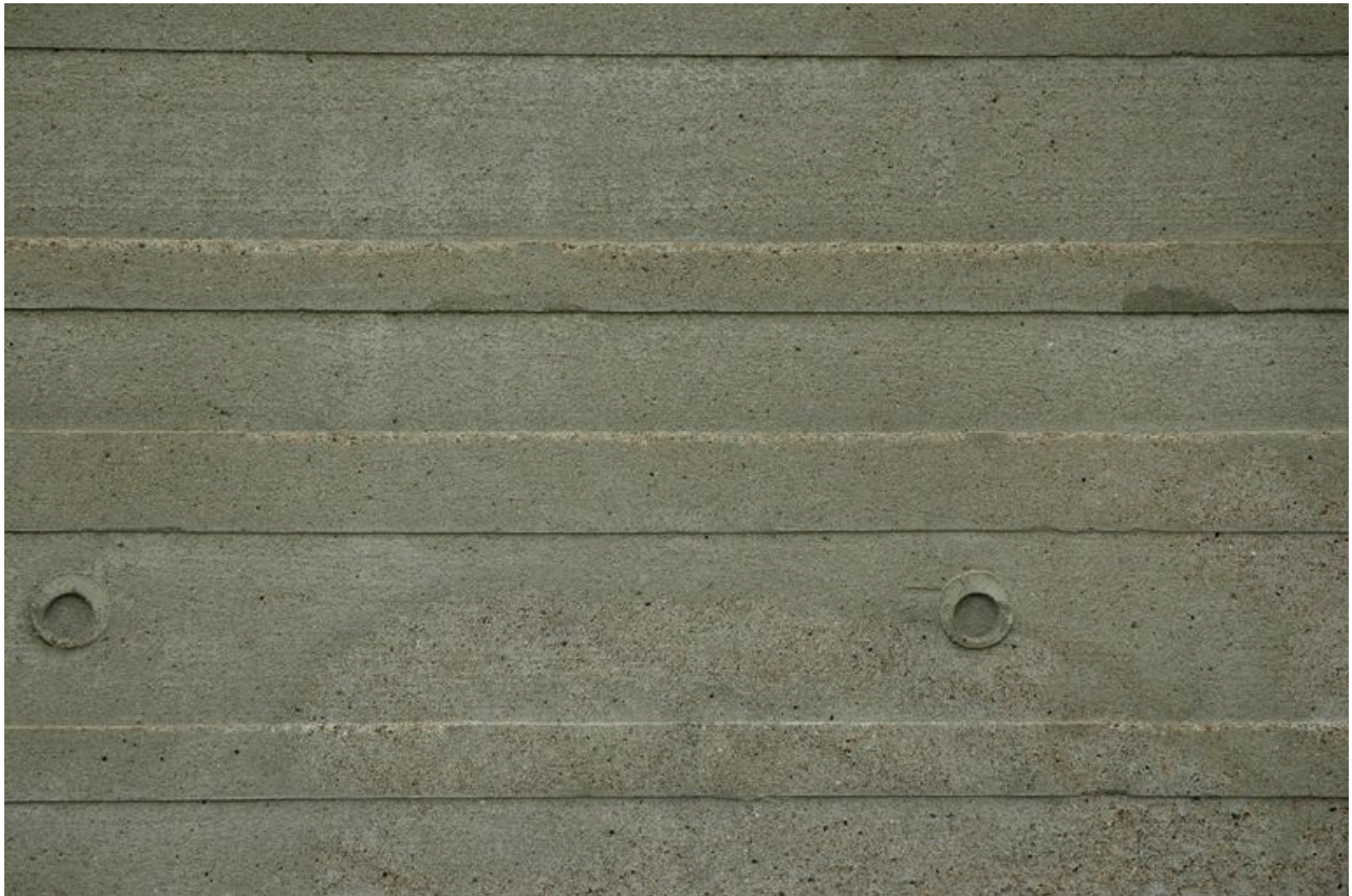
Détail du béton brut de décoffrage
