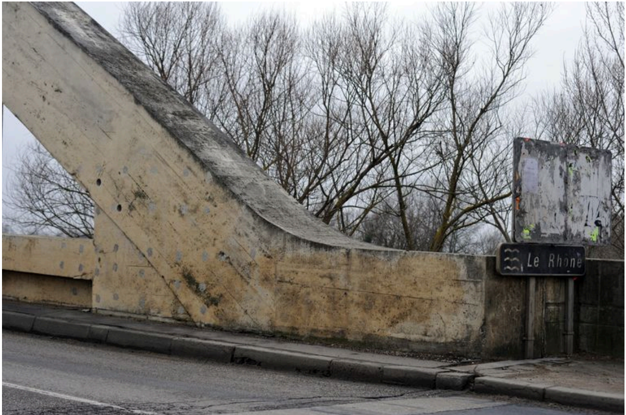
Arche droite, de dessus, face aval, vue partielle : extrémité au niveau de la jonction avec la culée (depuis la rive droite)
