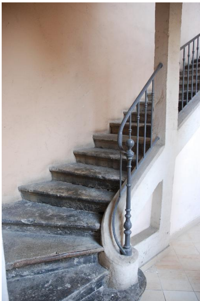
Vue de la première volée de l'escalier
