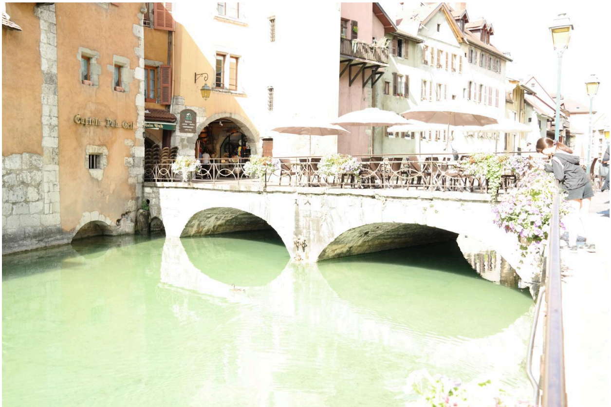
Pont Morens, vue de la face amont
