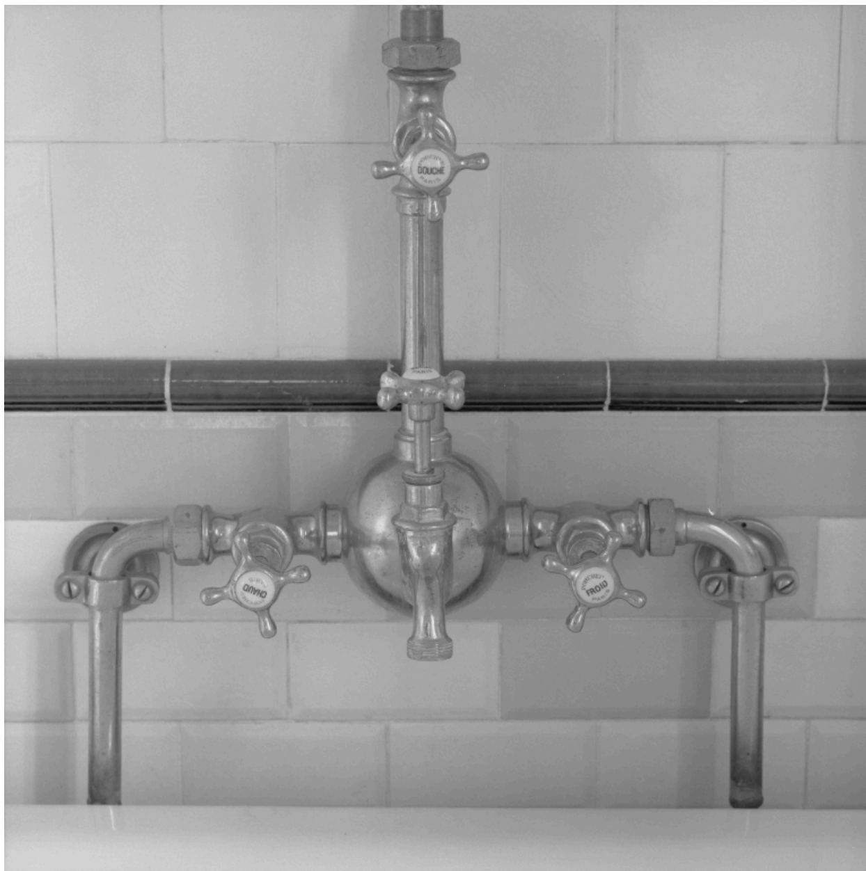
Salle de bains et des toilettes du premier étage : détail de la robinetterie de la baignoire.
