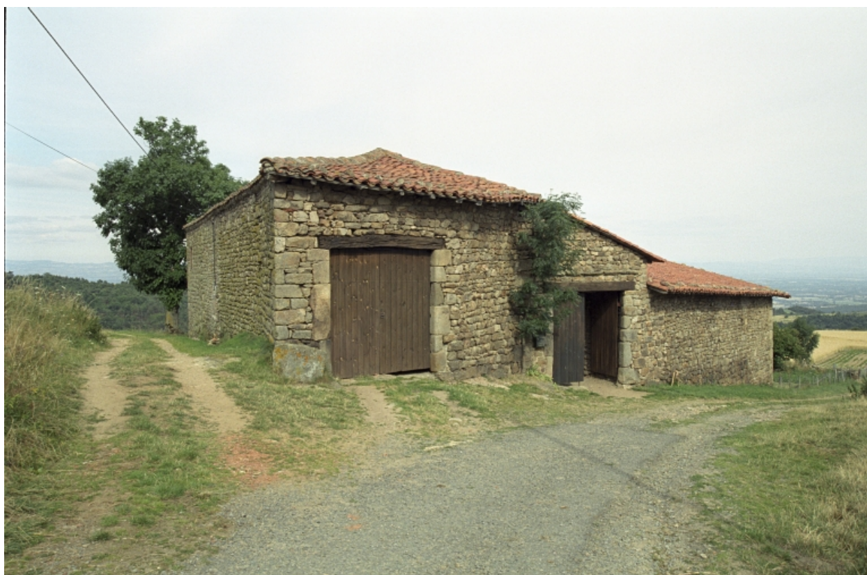
Vue d'un mur pignon : agrandissements successifs.
