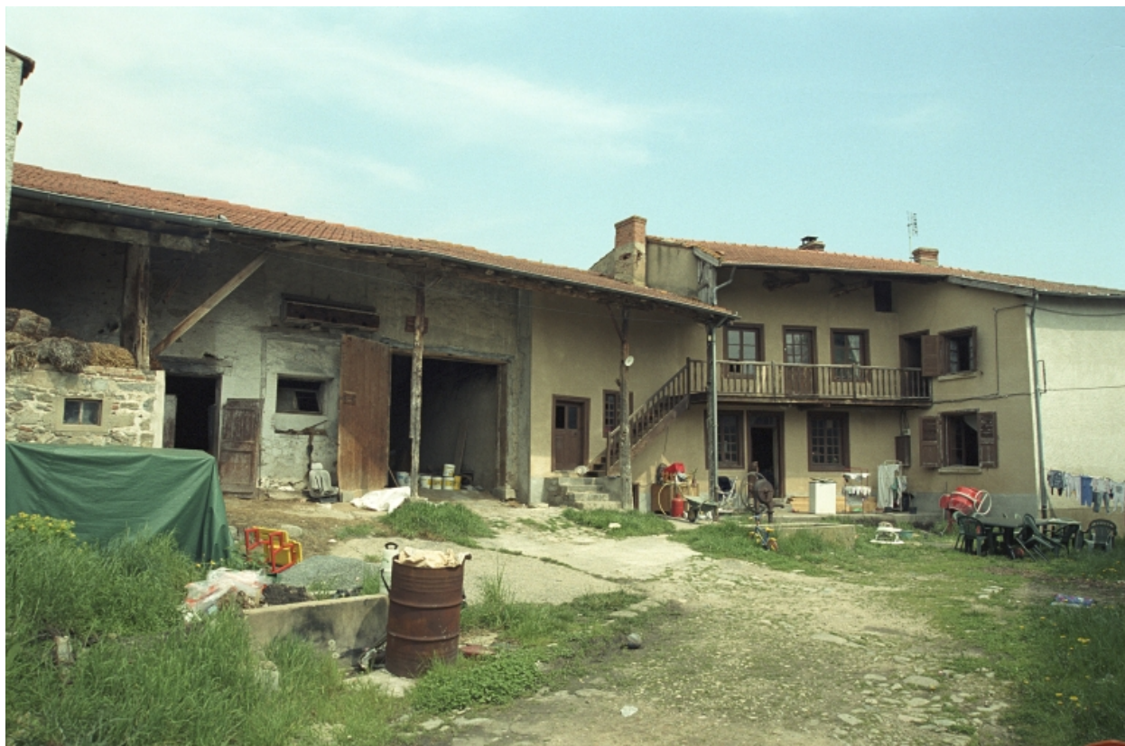
Premier ensemble. Bâtiment nord : vue d'ensemble depuis la cour.
