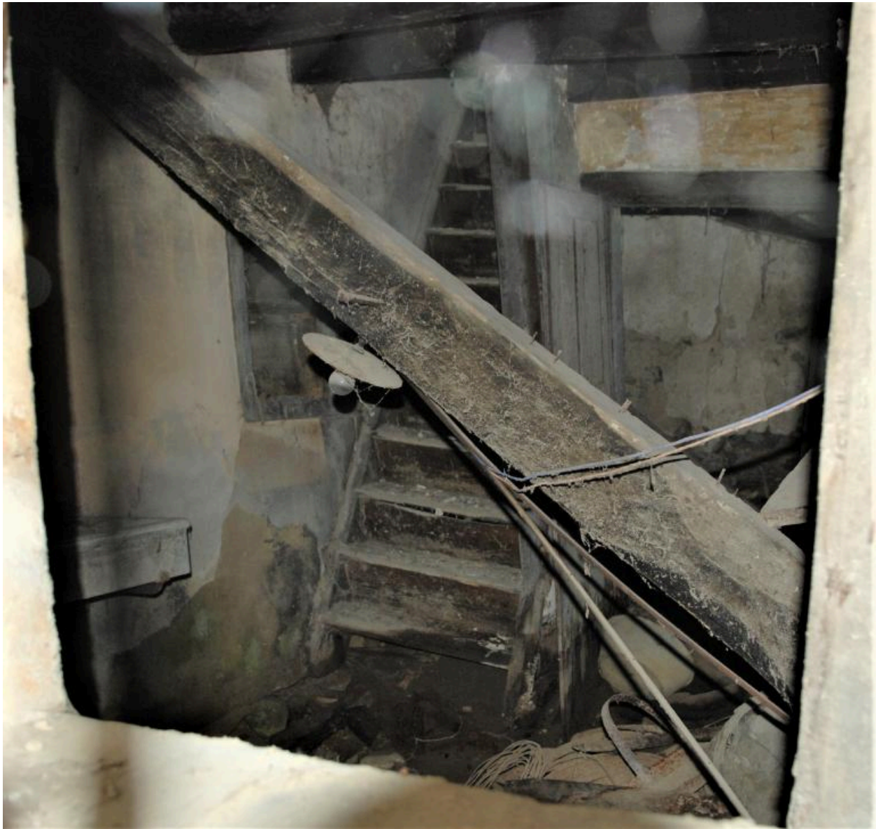
Vue partielle intérieure : escalier à gauche.
