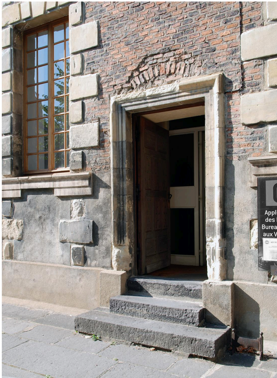
Aile nord : détail d'une porte
