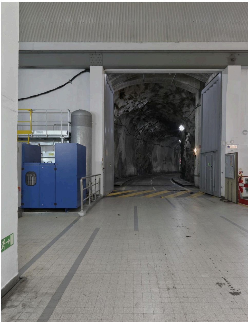
Débouché du tunnel d'approvisionnement des matériels dans la salle des robinets
