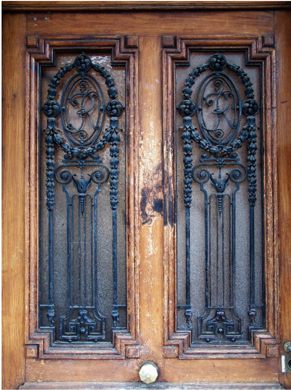
Détail de la porte d'entrée
