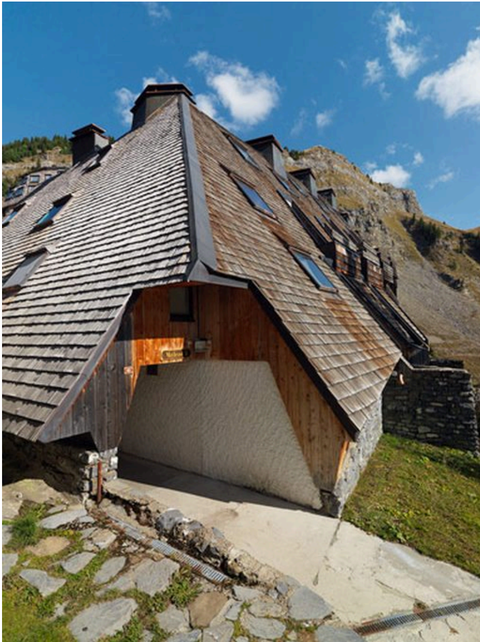
Entrée des Mélèzes 1, côté sud (amont)
