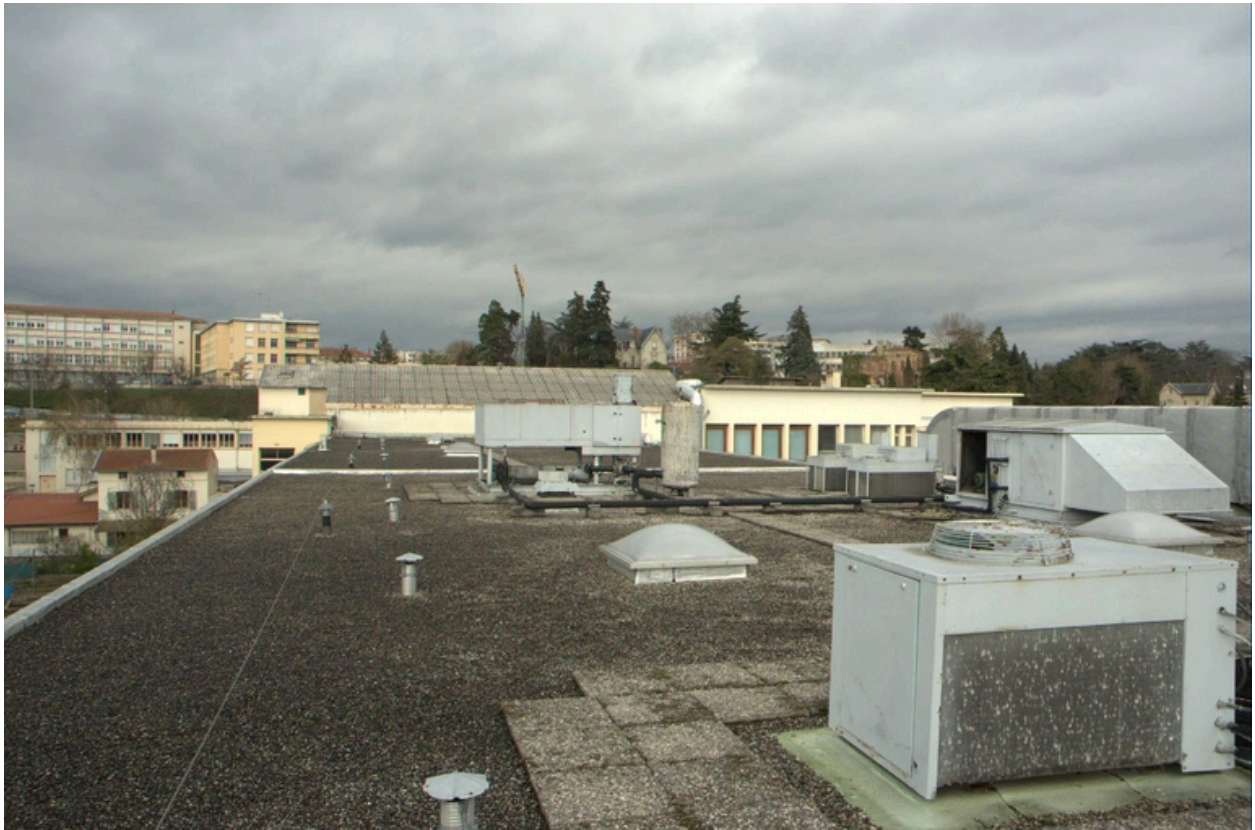
Vue des toits terrasse
