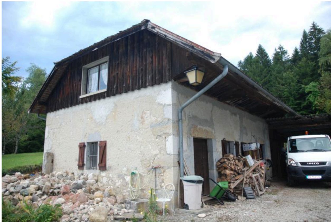
2017 C10 1017, la Tuilière, ferme. Vue d'ensemble de trois-quarts arrière des communs de la ferme.
