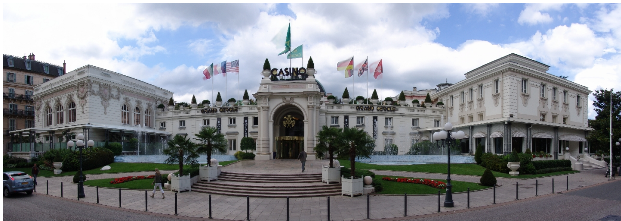
Vue d'ensemble depuis la rue
