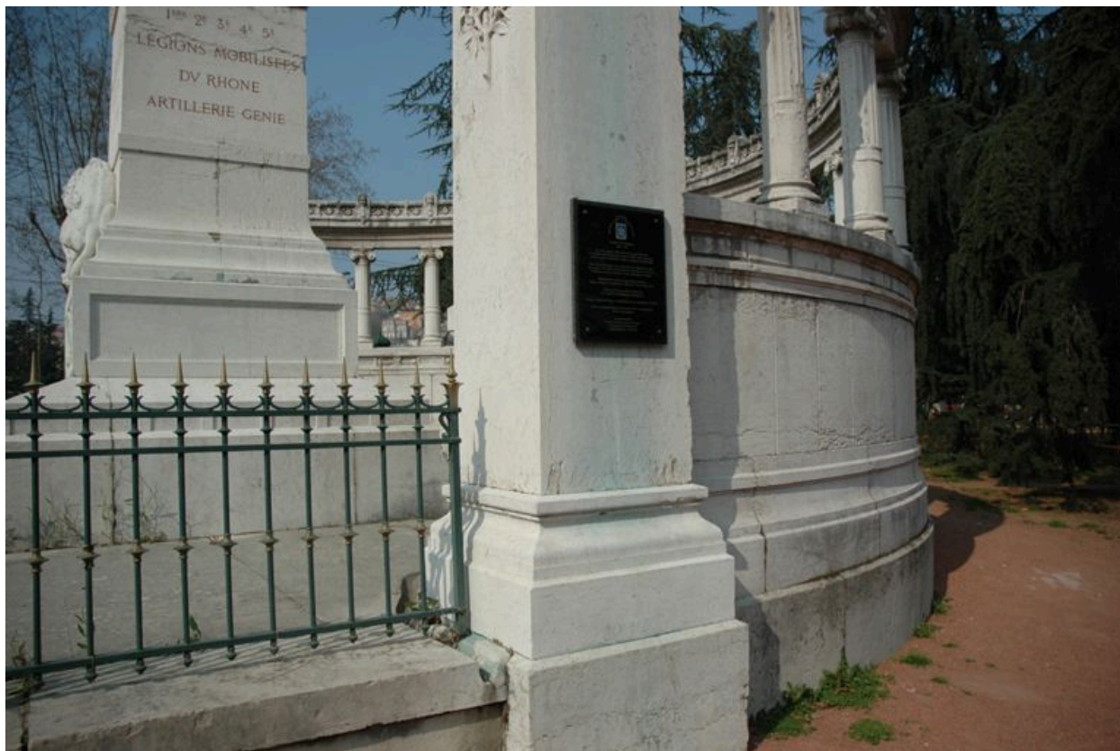
Détail de la plaque ajoutée en 2007 située au revers de l'exèdre orné d'une colonnade
