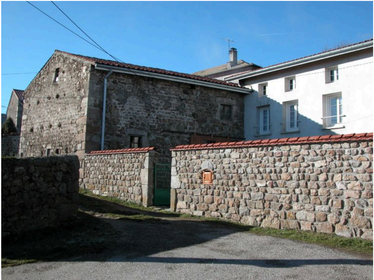
Vue d'ensemble de la partie gauche de la ferme.
