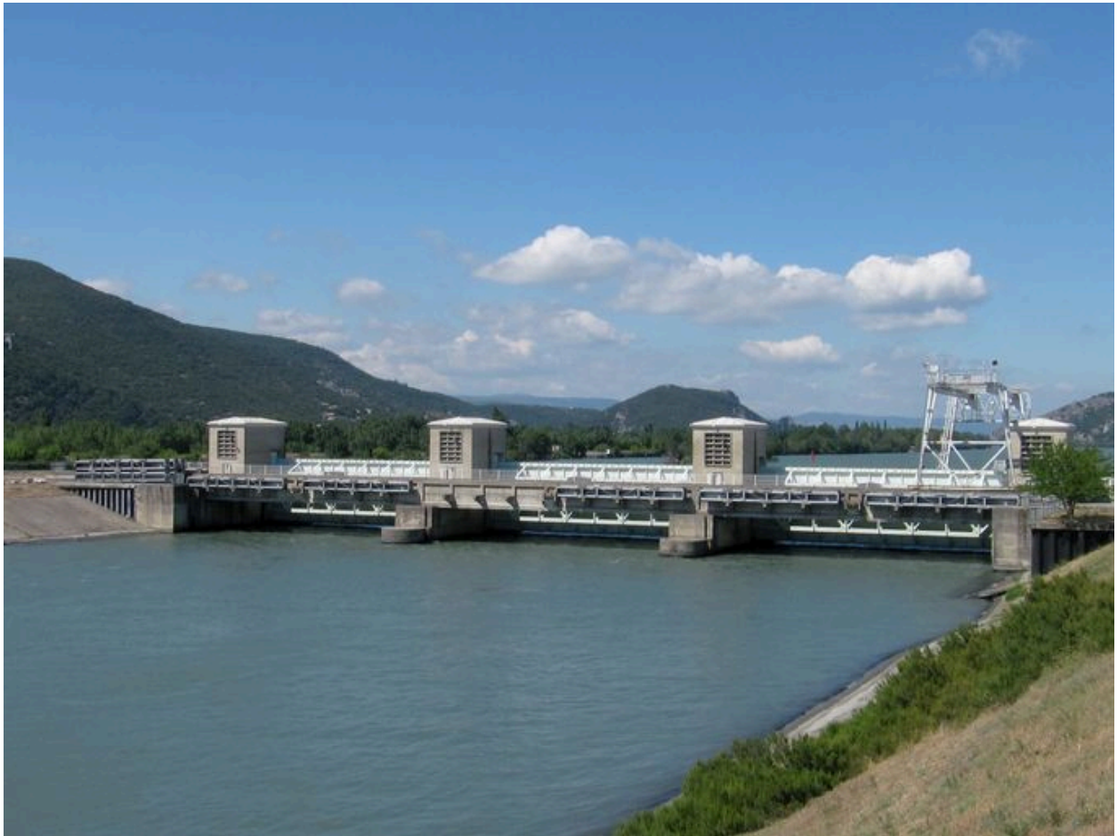
Barrage amont : vue générale, face aval
