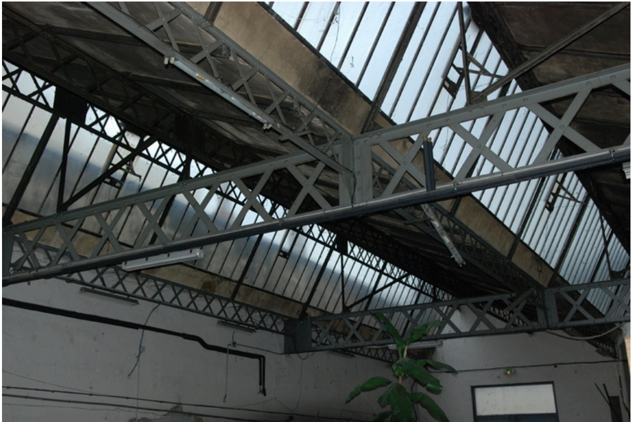
Détail poutre métallique à croisillons
