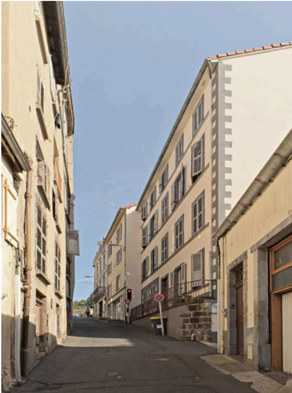
La rue en direction du haut, vers la rue de Lyon.
