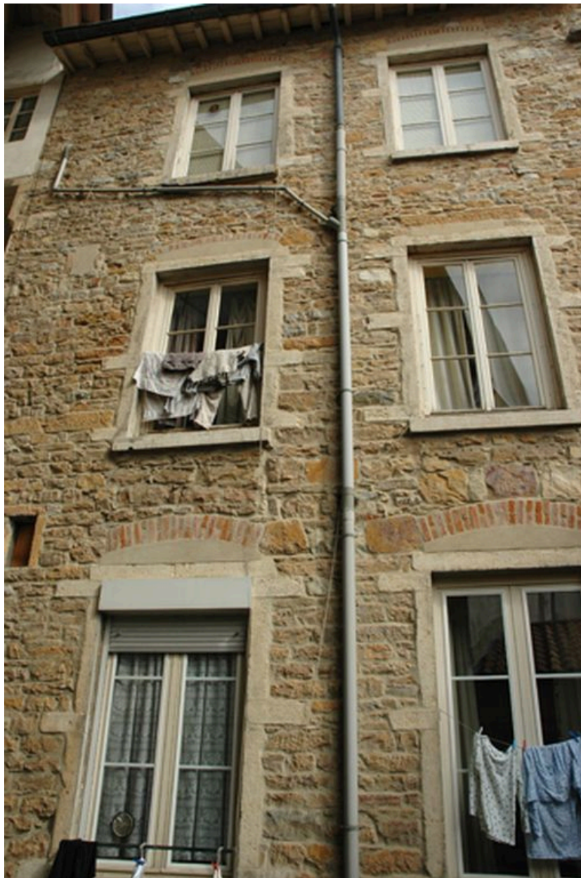
Façade sur cour du bâtiment sur rue
