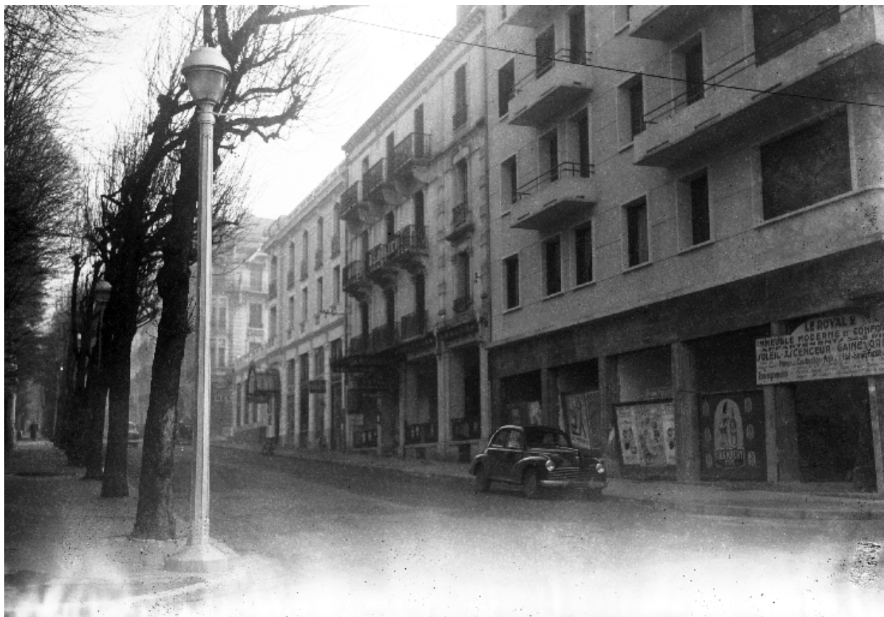
Façade sur rue depuis l'ouest
