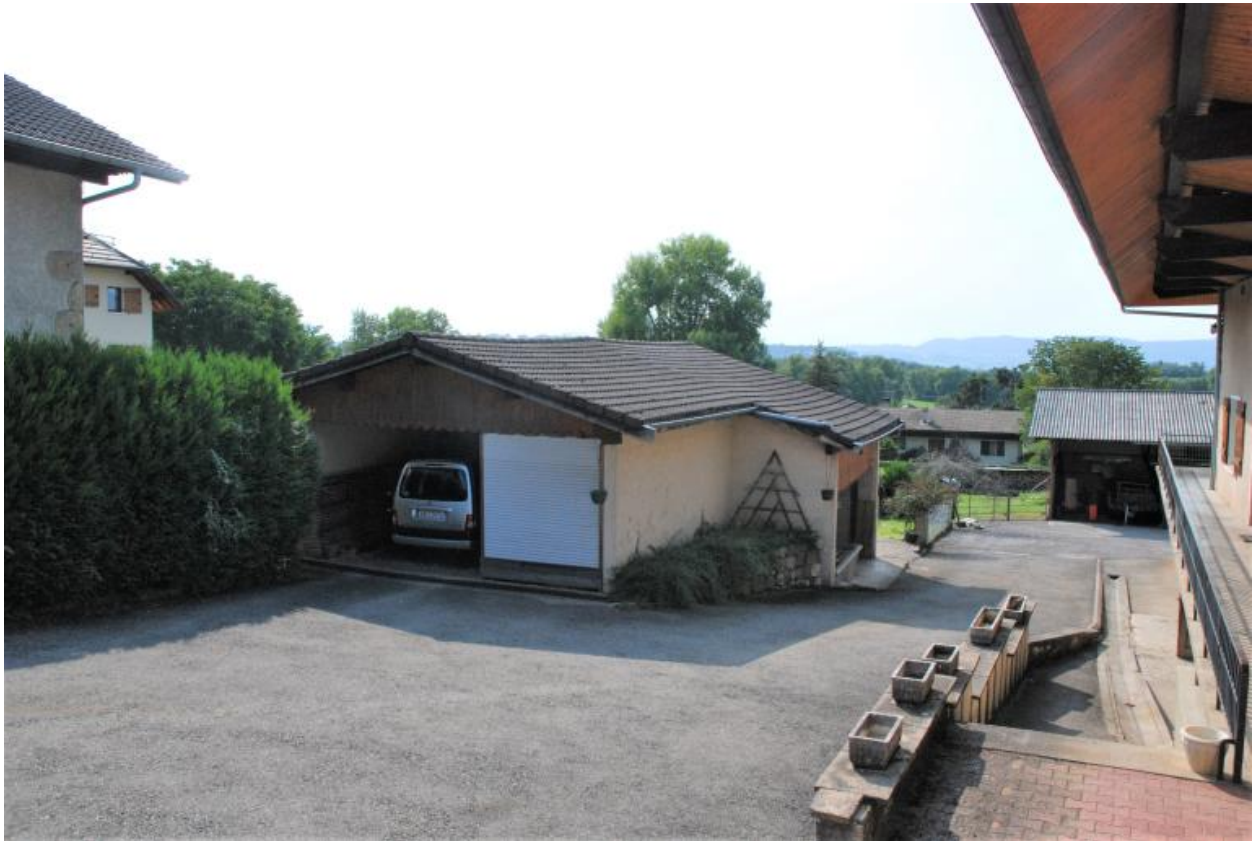
Viuz-Nord, C4 217, ferme. Vue d'ensemble de l'ancienne boulangerie se trouvant dans la cour de la ferme.
