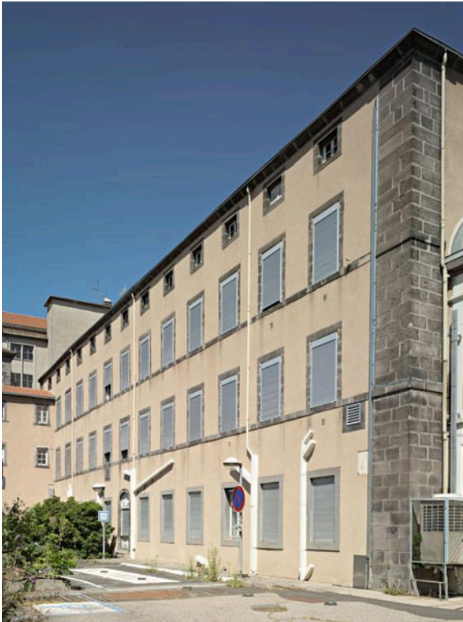
Hôtel-Dieu de Clermont-Ferrand. Le Refuge, façade sud (vue du sud-est).
