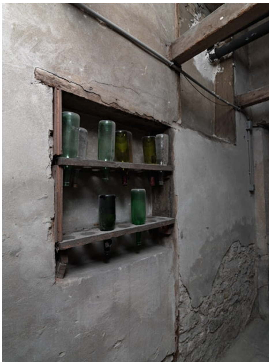
Bâtiment R. Porte-bouteilles des dépendances du rez-de-chaussée
