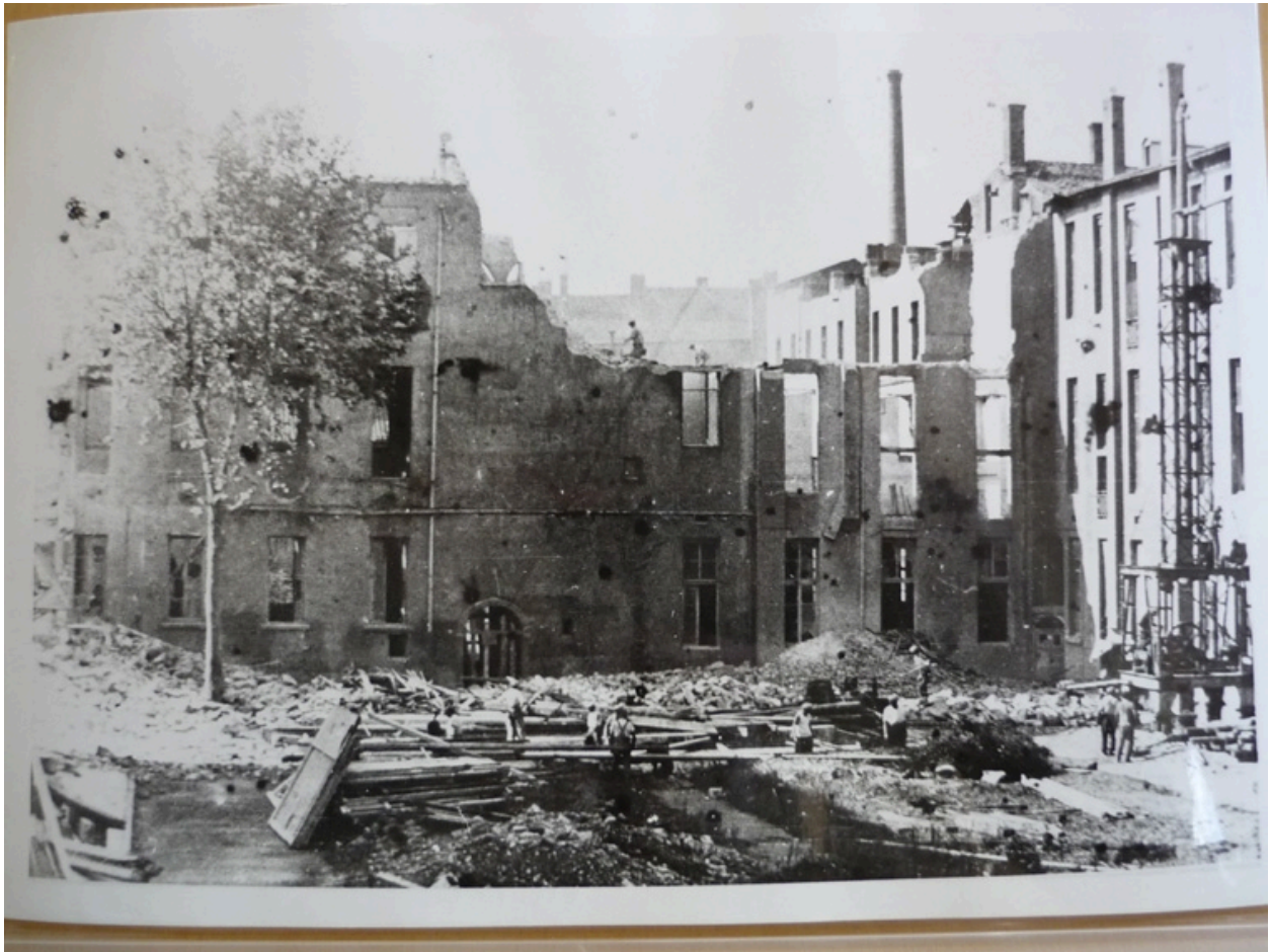
Vue d'ensemble, démolition, 1934. Photographie AC Lyon. 2PH31
