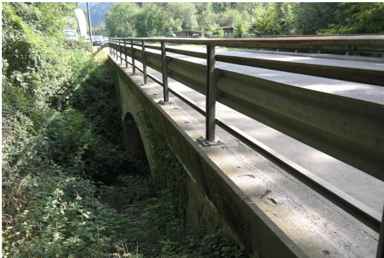
Pont du Maravand, vue de la face amont
