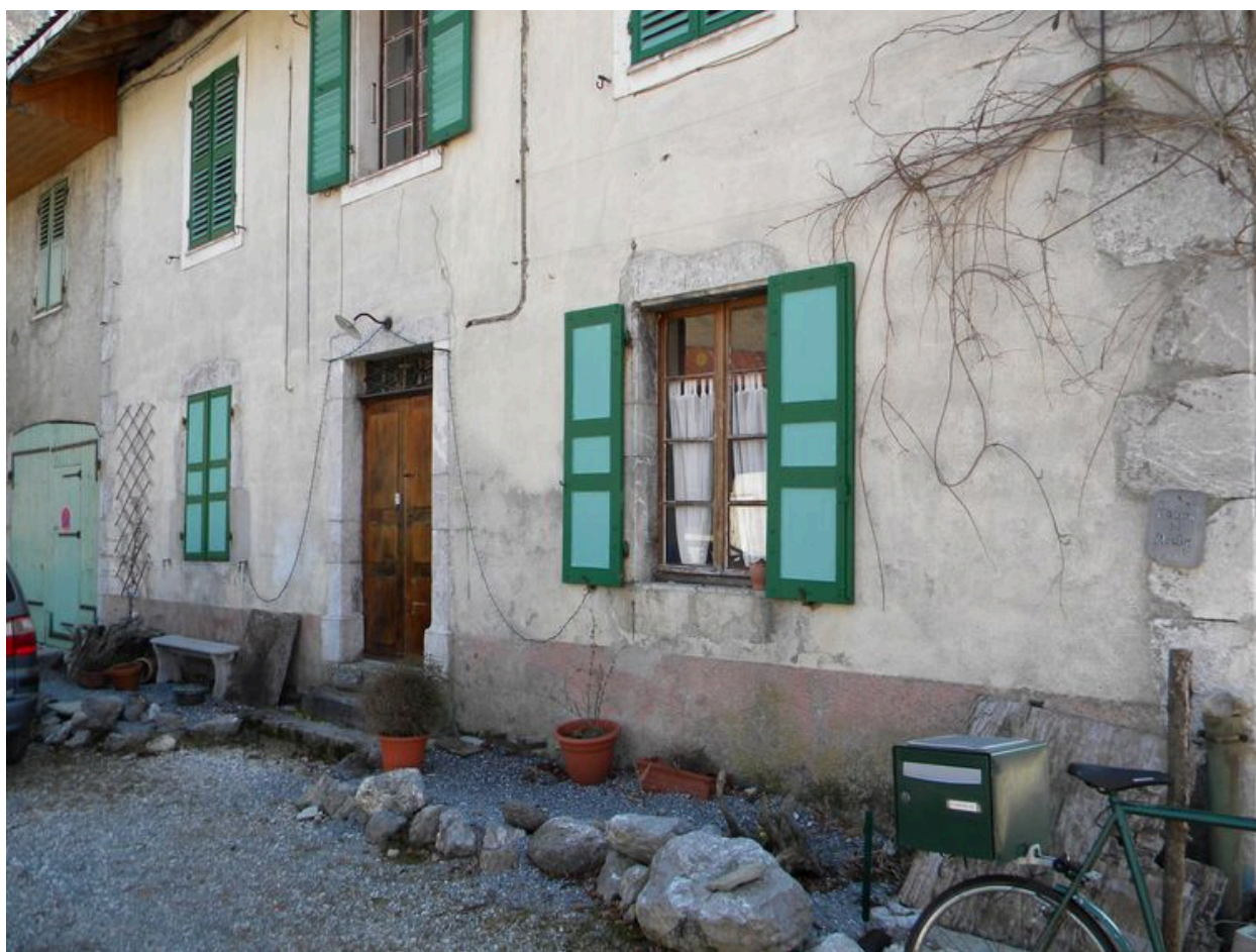
Vue de la façade de la maison d'habitation du meunier.
