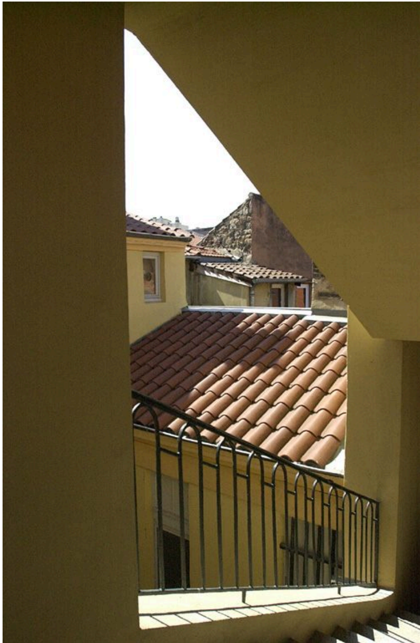
L'escalier au dernier étage : vue en direction de la rue de la Monnaie
