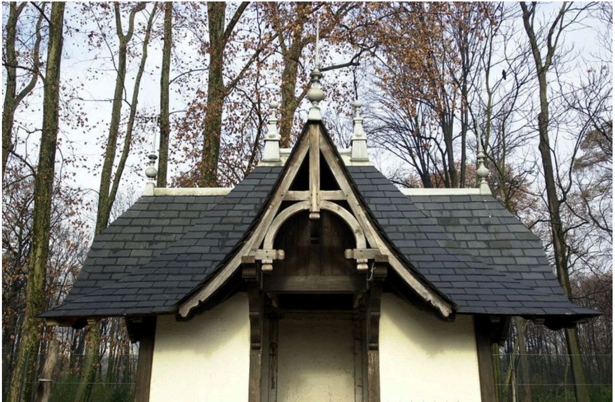
La maison des grues : la toiture
