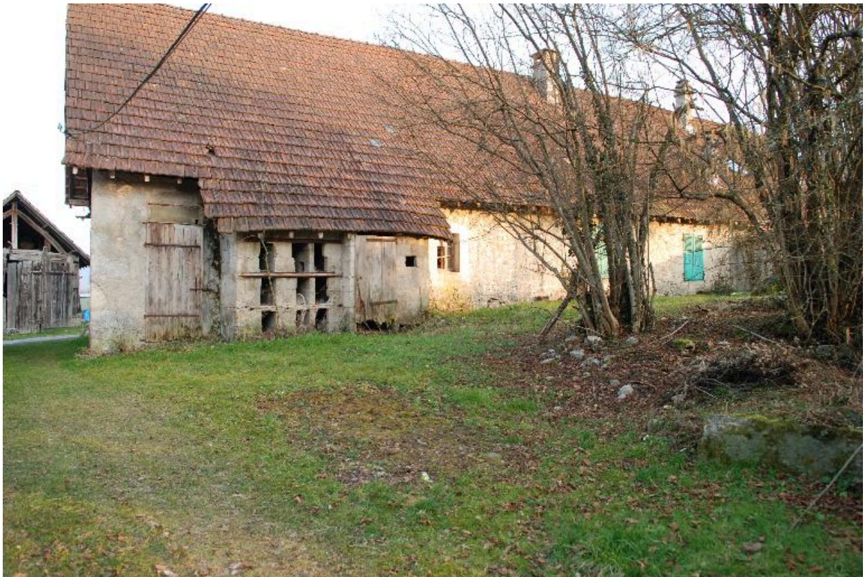
Vue d'ensemble de la façade arrière.
