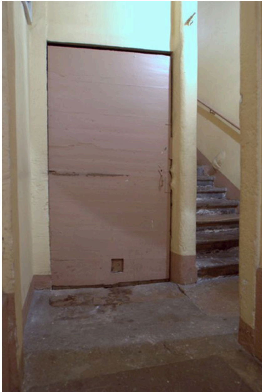
Vue de la porte de la cave et du départ de l'escalier
