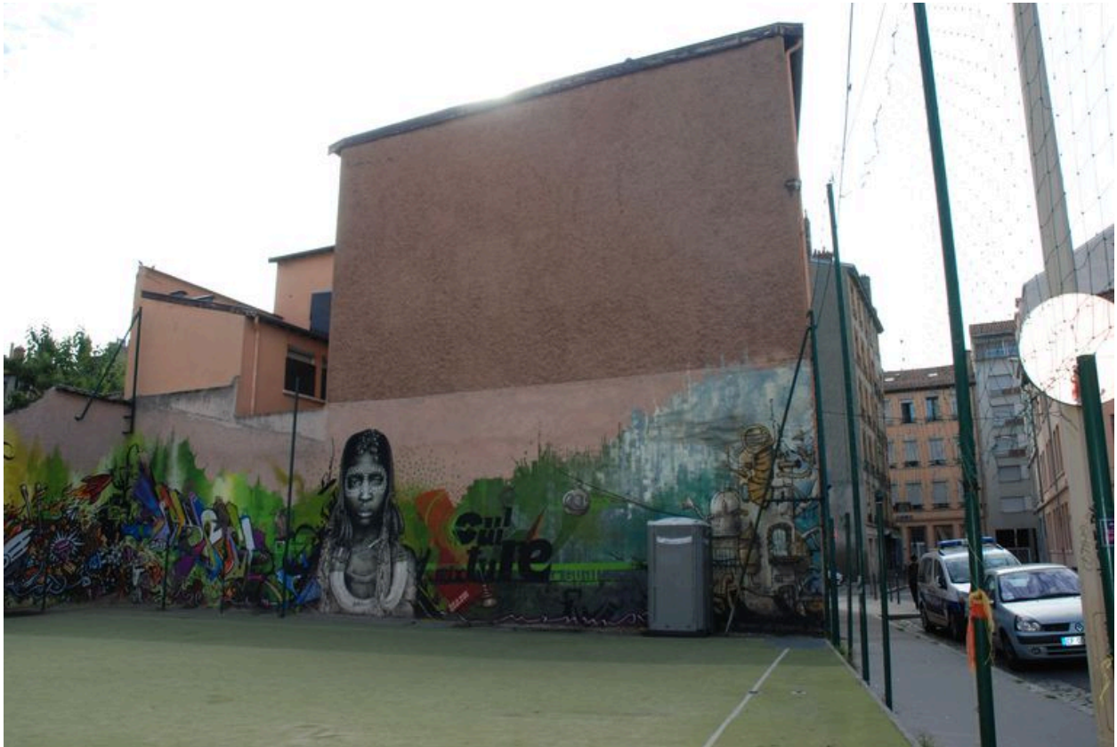
Vue du pignon ouest (état août 2012).
