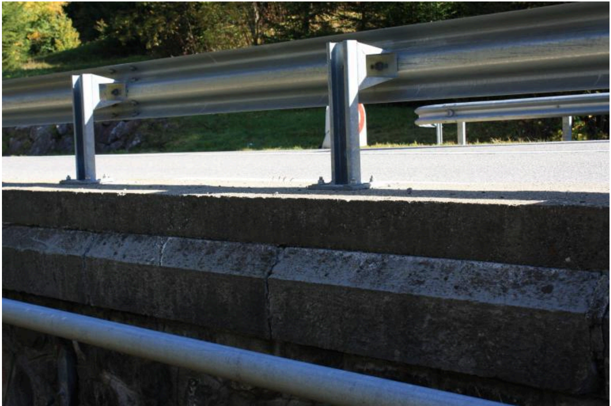
Pont du petit Nant, détails plinthe, revêtement et glissière
