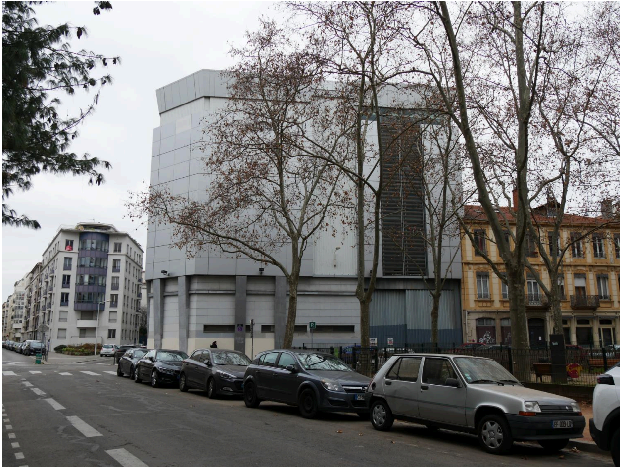
Vue d'ensemble dans l'espace urbain
