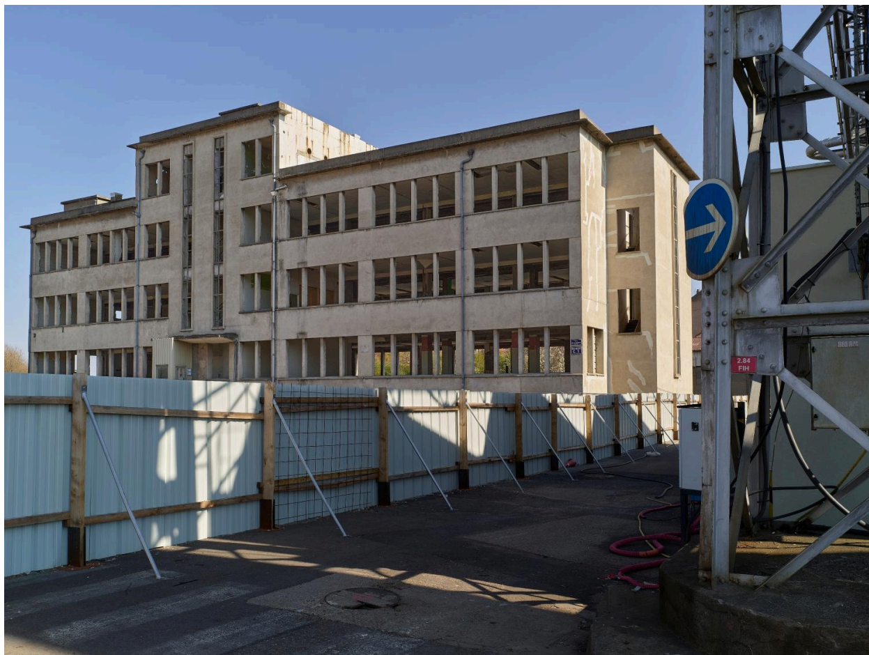
Élévation nord du bâtiment C1 (état 2022 après désamiantage).
