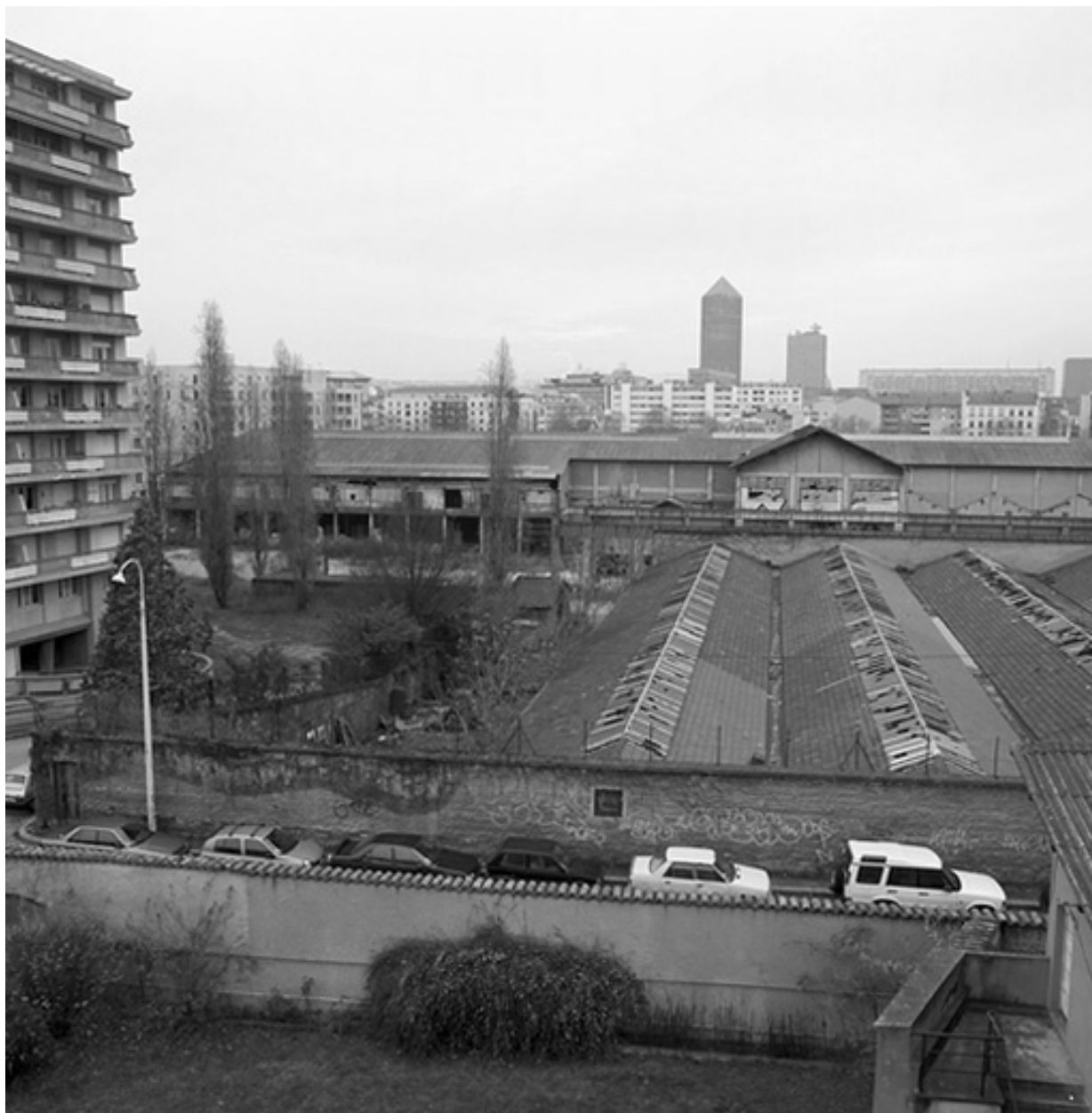
Vue d'ensemble zénithale sud
