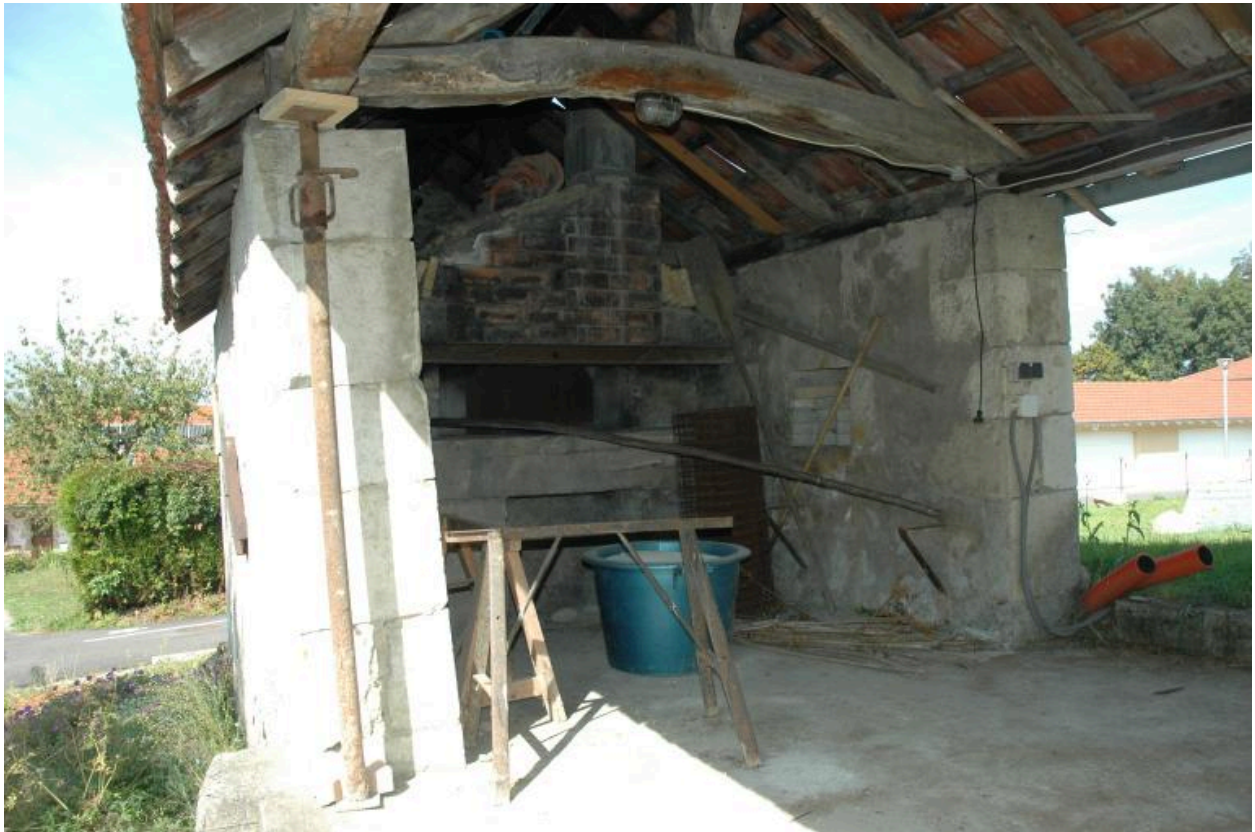
Vue intérieure du four à pain.
