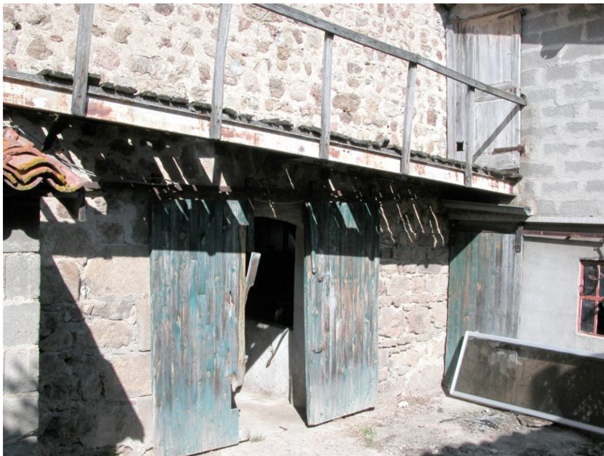
Détail du portail d'accès à l'étable des communs de la parcelle 259.
