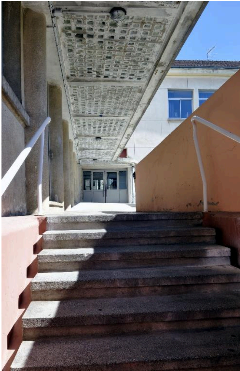
Escalier couvert, dernière volée, et auvent protégeant l'entrée du bâtiment B
