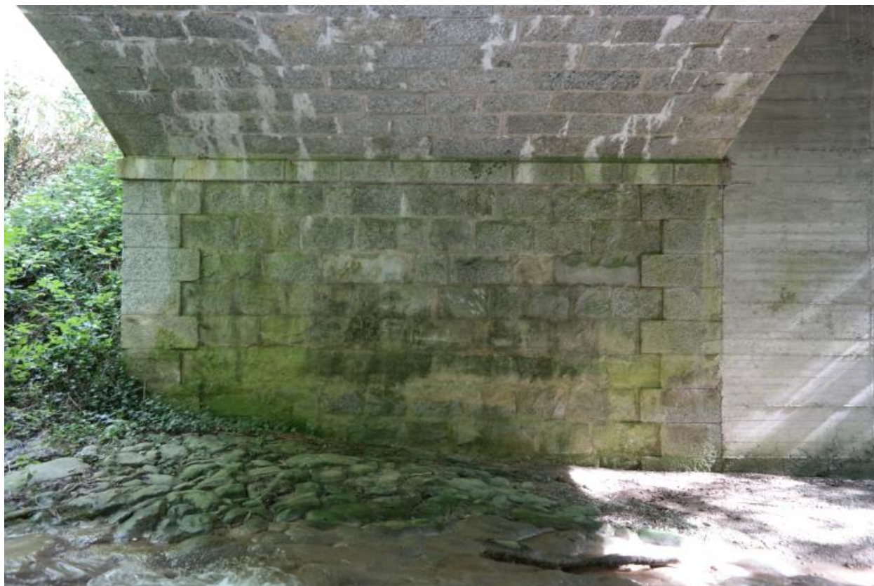
Pont du Maravand, détail de la culée rive gauche
