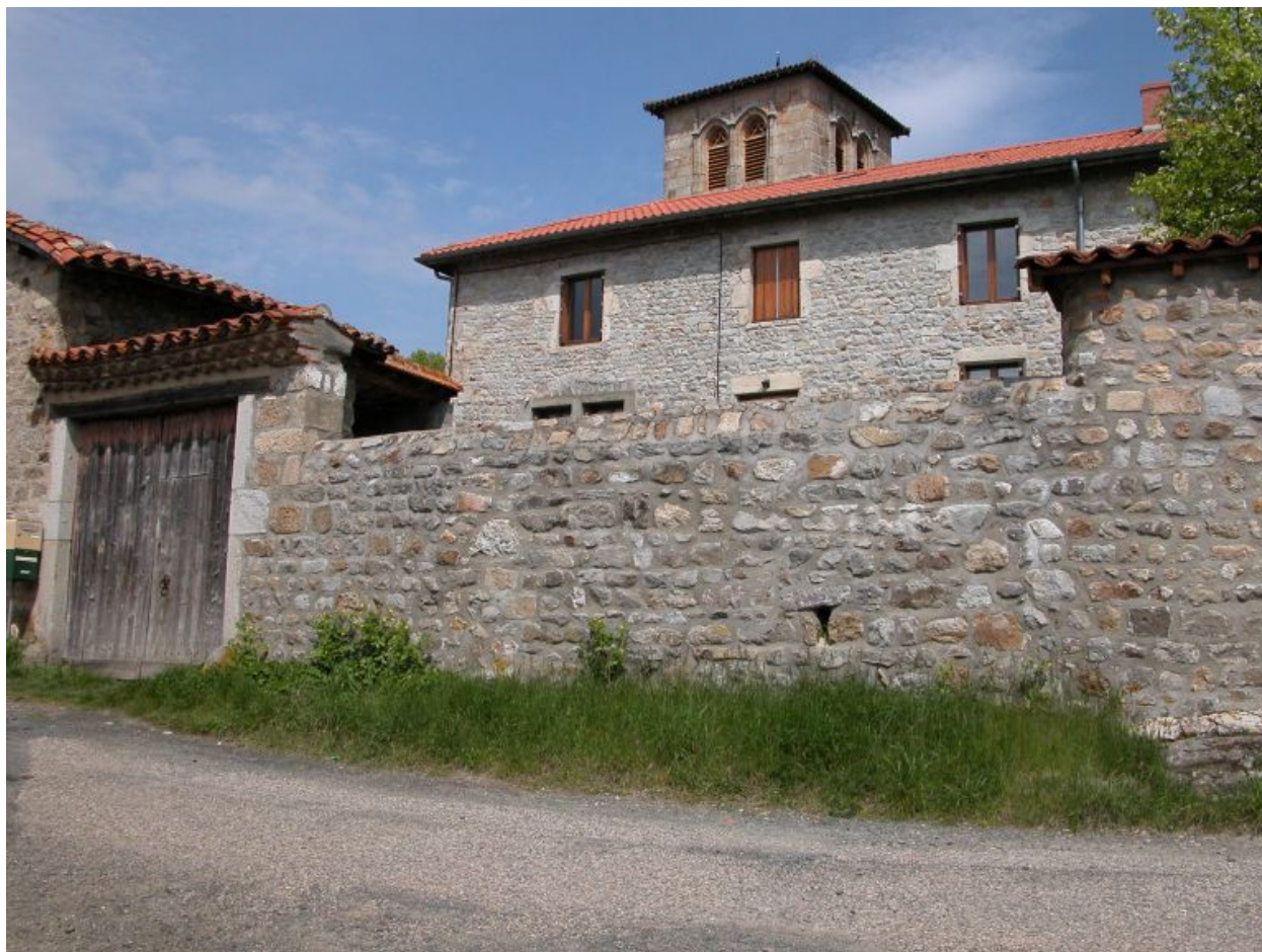
Vue d'ensemble extérieure et partielle du presbytère.
