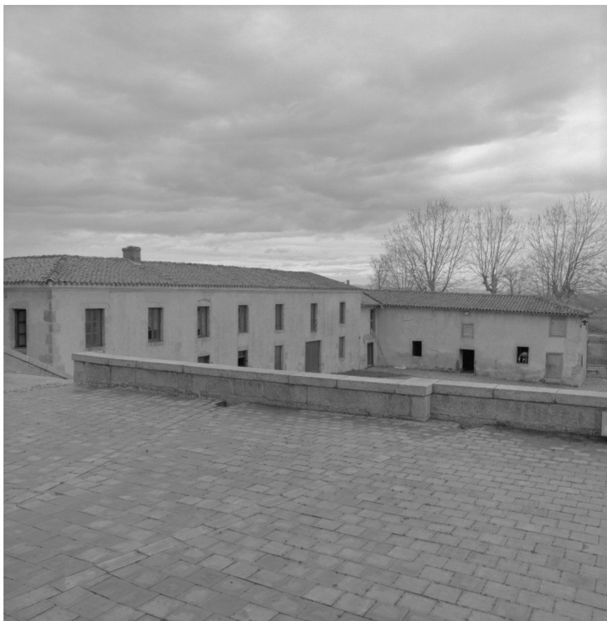
Vue des communs nord, depuis la terrasse de la demeure, du sud-ouest.
