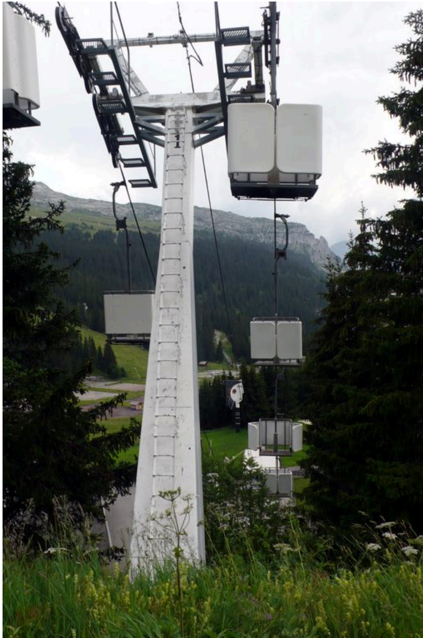
Pylône de la télébenne des Grands Vans
