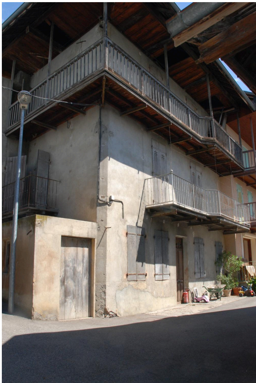
Maison de vigneron (2018 C2 315).
