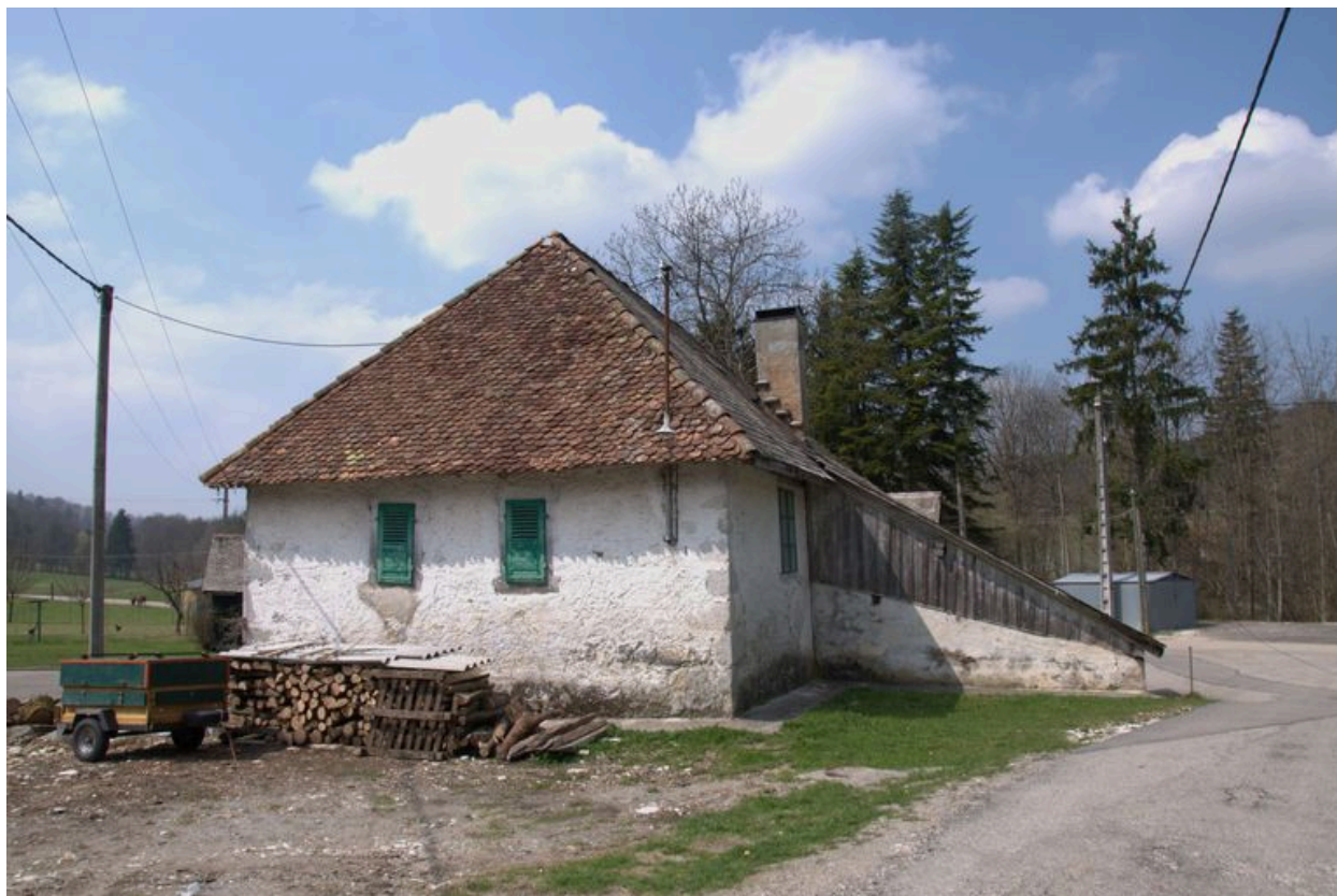
Façade postérieure du bâtiment du moulin contigüe à la route du Vuaz
