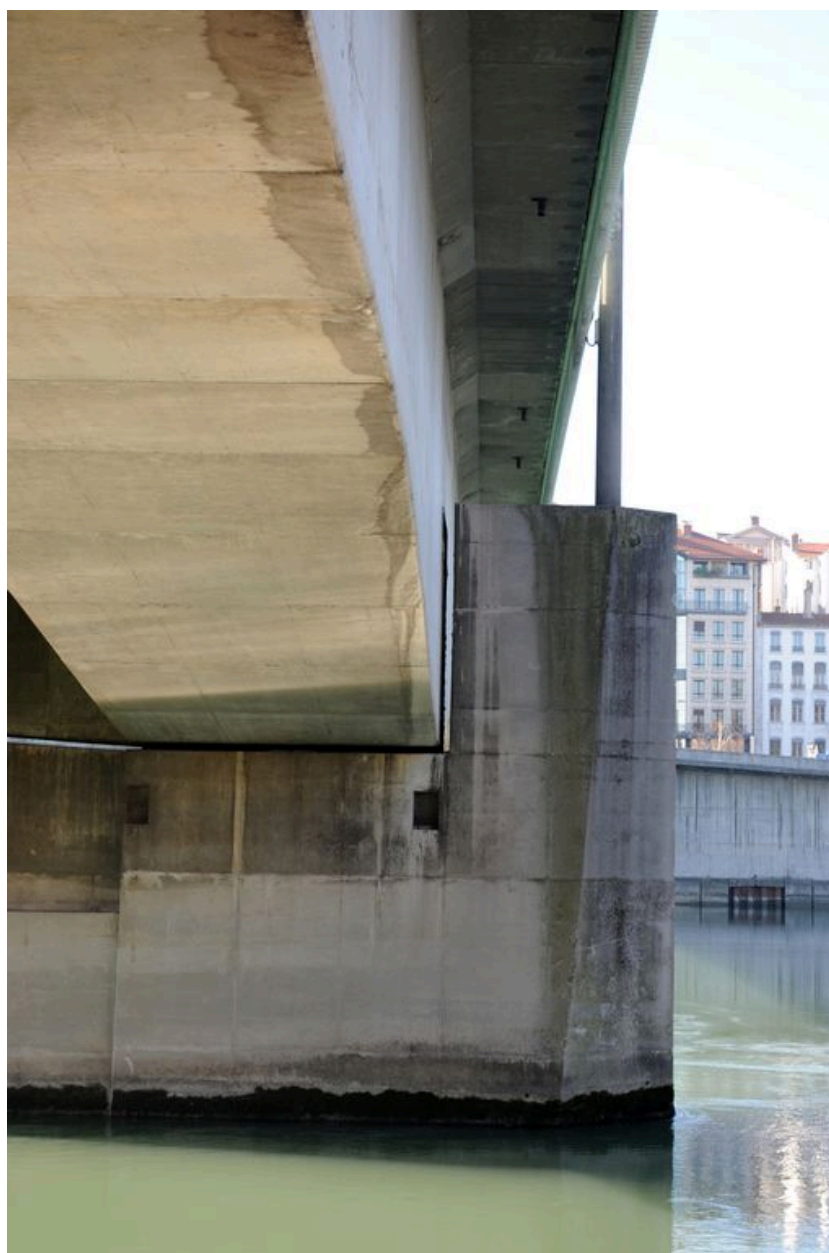
Pile, de côté, face amont, vue partielle (depuis la rive gauche)
