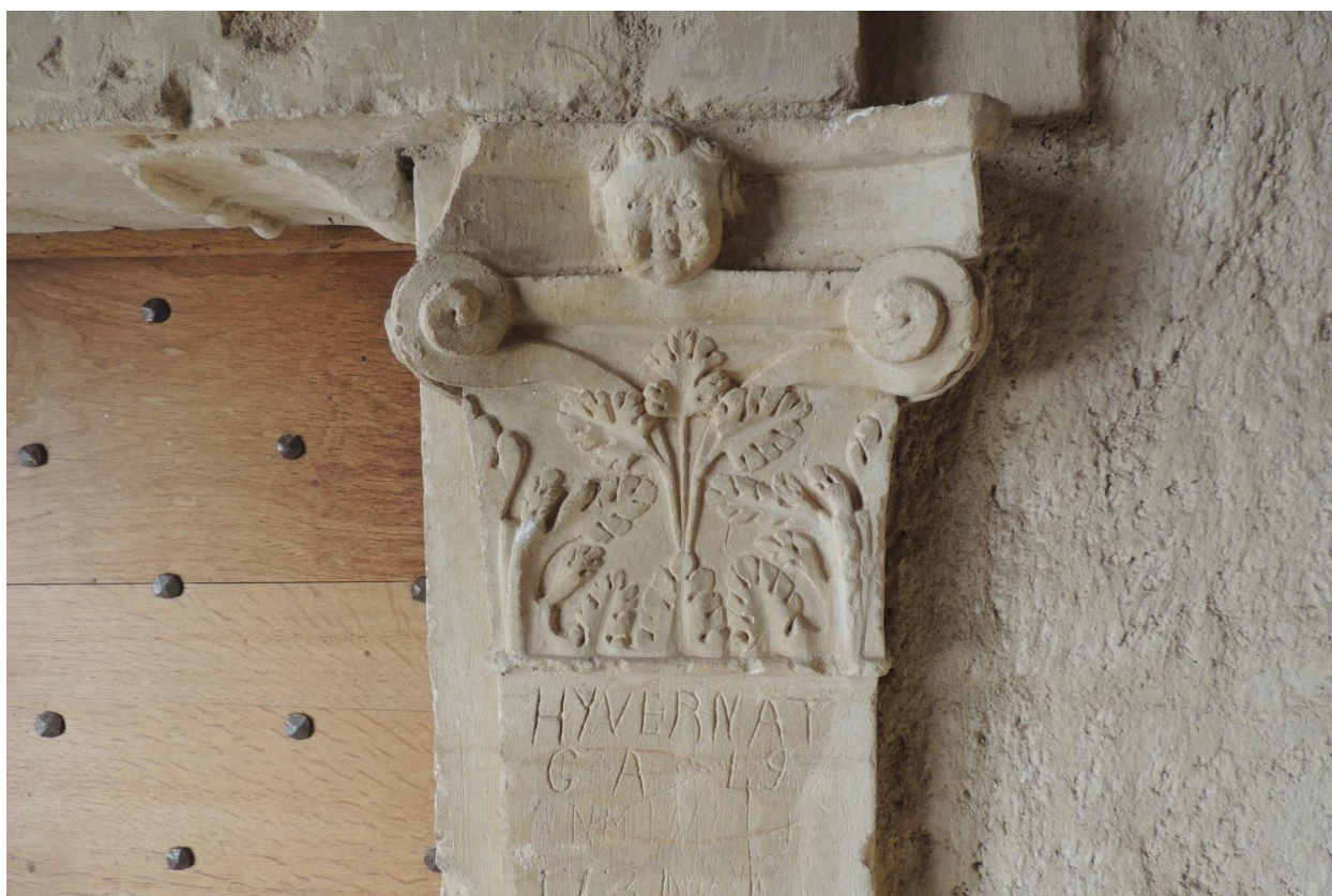
Chapiteau du pilastre droit, graffiti "HIVERNAT".
