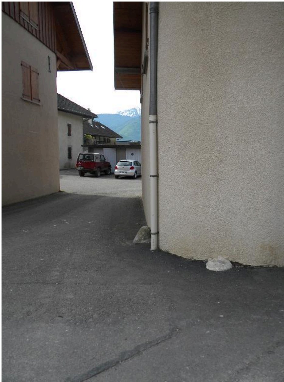
Vue d'un passage cocher avec chasse roue entre deux bâtiments.
