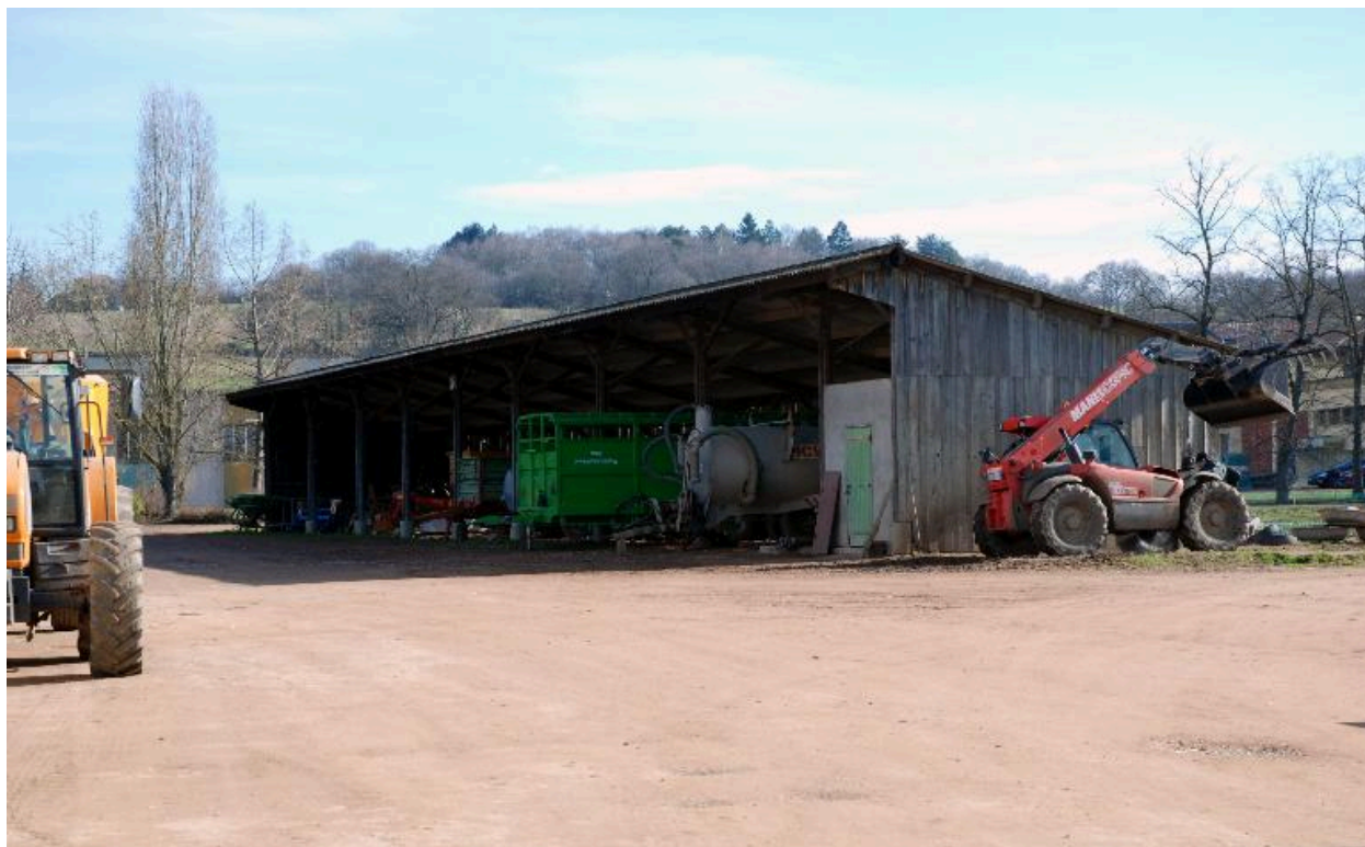
Hangar au sud-est du bâtiment d'exploitation
